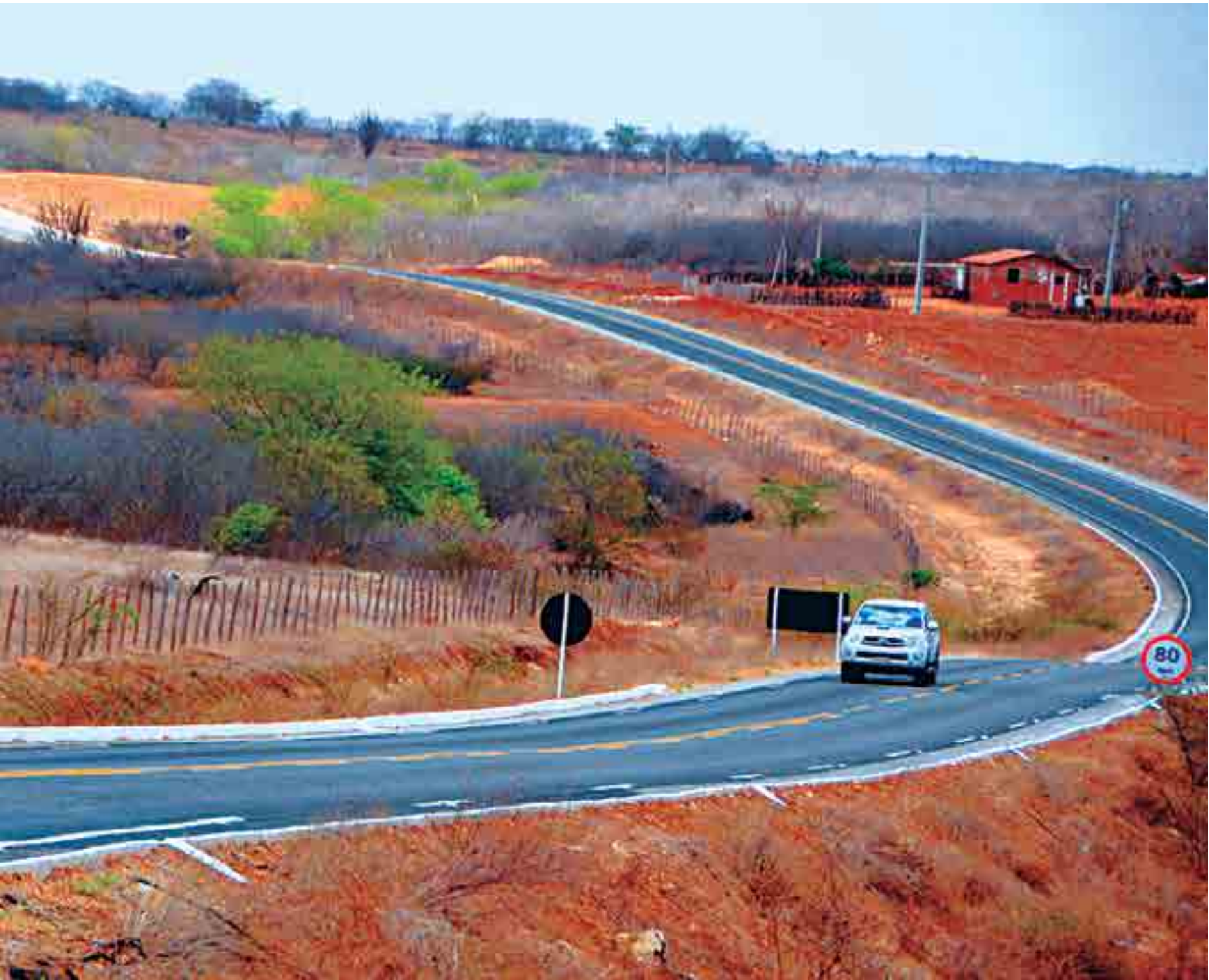
O Governo do Estado também vem executando, por meio do DER-PB, os programas Mais Trabalho e Estrada Segura e termina 2017 com mais 111,1 km de obras rodoviárias em andamento
